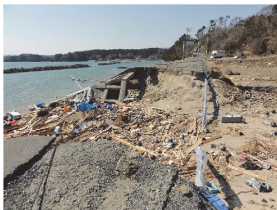
写真-6.1 離岸堤開口部の流れの集中に伴う海岸護岸の洗掘状況（宮城県南三陸町）
