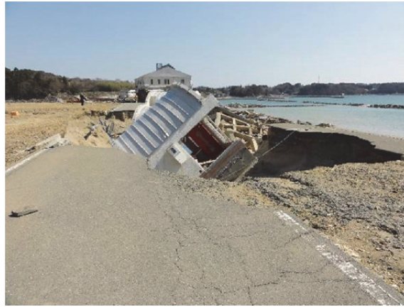
写真-6.2 洗掘に伴う中詰材の吸出しによる海岸護岸・背後地民家の倒壊状況 （宮城県南三陸町）
