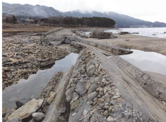
写真-6.3 越流・裏法尻洗掘による海岸護岸の倒壊状況（宮城県南三陸町）
