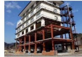
東日本大震災の調査で見られた外壁材の脱落事例
