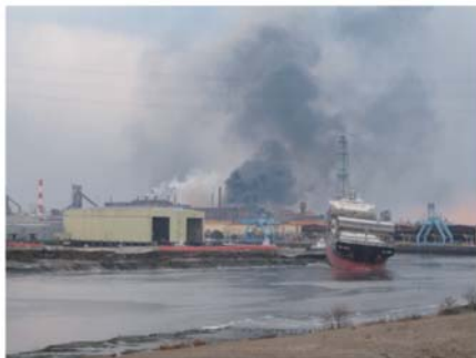
船舶の衝突による岸壁構造物の損傷
