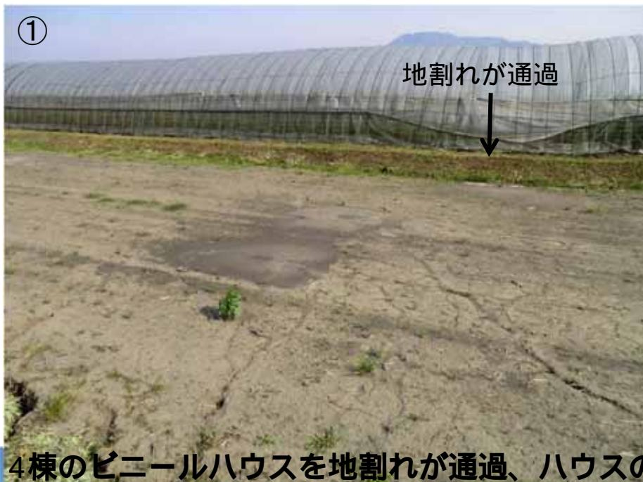
4棟のビニールハウスを地割れが通過、ハウスの中は陥没・噴砂
