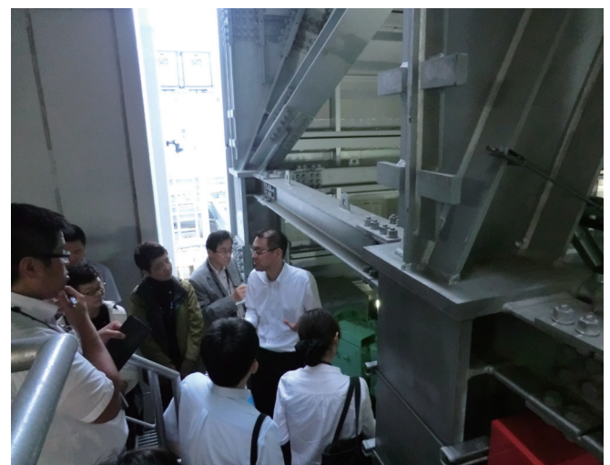
写真3 屋上の制震装置を前にしての説明の様子、活発な質疑が行われた。
