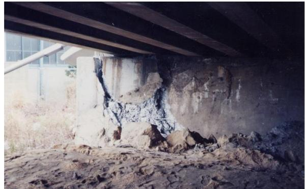
写真-2 液状化による橋台の重大な損傷
