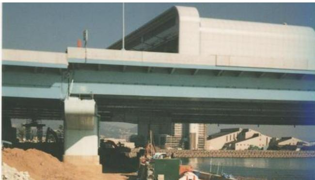
写真-1 液状化によって落橋寸前となった事例
