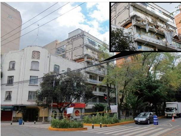
図4 6階部分に被害が集中した構造物
