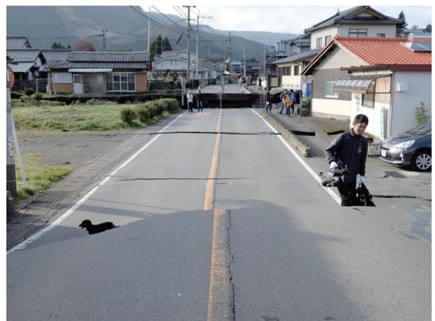
図5 熊本地震ともなつて阿蘇カルデラ内牧温泉付近に生じた地盤側方移動に伴う陥没(熊本大学鳥井真之特任准教授撮影)
