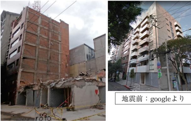
図3 地震前後の倒壊した建物の様子
