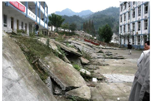
写真3 四川地震の地震断層による白鹿中心学校校庭。左側(北西)校舎が2mほど相対的に隆起。
