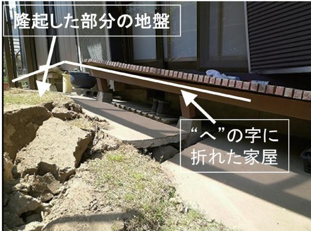
写真4 液状化で地盤が隆起して破壊した家屋
