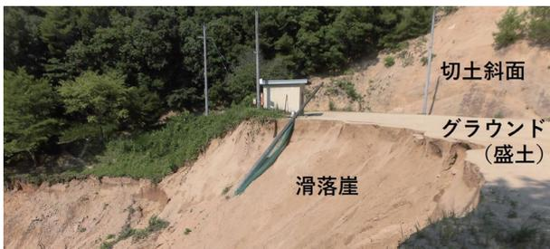
写真5 渓流に盛土で造成されたグラウンドの滑落崖
