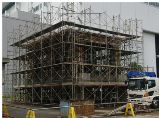
写真 試験体の施工状況
