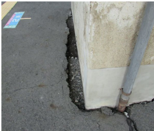
プラットフォームの橋脚損傷(左上写真の遠景は鏡石図書館)
