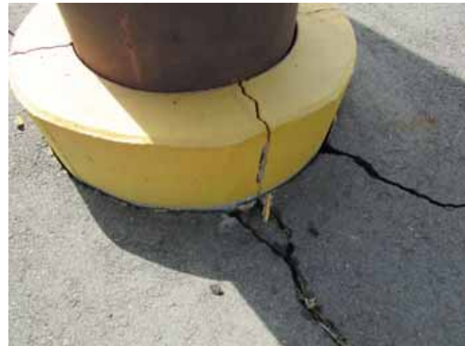
プラットフォームの橋脚損傷(左上写真の遠景は鏡石図書館)
