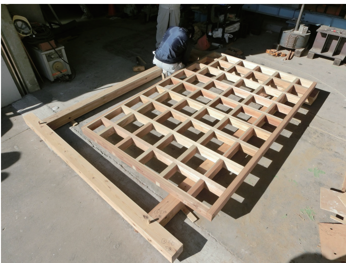
写真5 間伐材を用いた木造補強壁の製作
