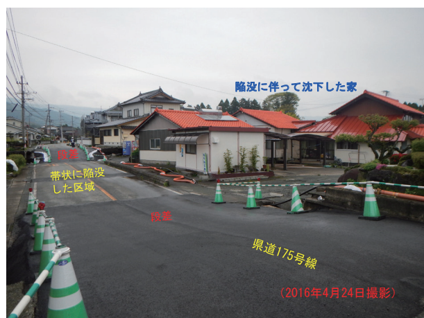
写真 1 狩尾地区で発生した帯状陥没
