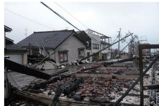
図3 複数の電柱の倒壊による道路閉塞<sup>6)</sup>
