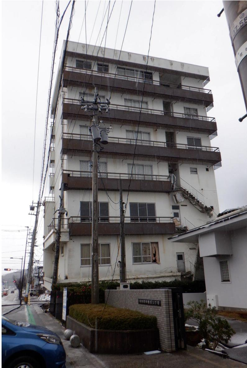
7階建てのビルが1m位沈下し、傾いていた。
