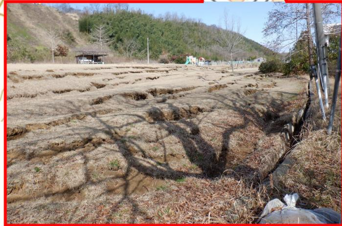
側方流動の上流部開始点は県道から150m奥。厚さ数m長さ150mの地盤が流れ出したのではなかろうか。
