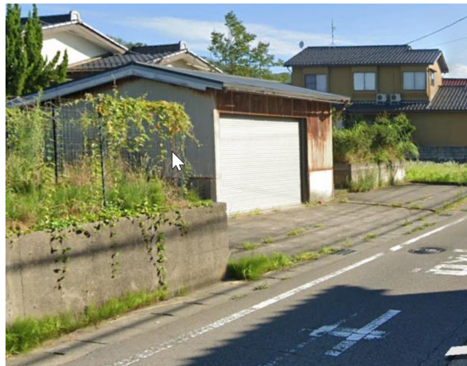
図59 図58の地震前の状況
