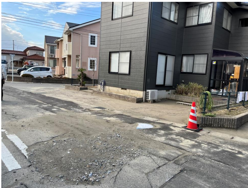
図29 新潟市西区ときめき西1-19-6 (37.874964N, 139.008439E, 方位角301.5535° )
