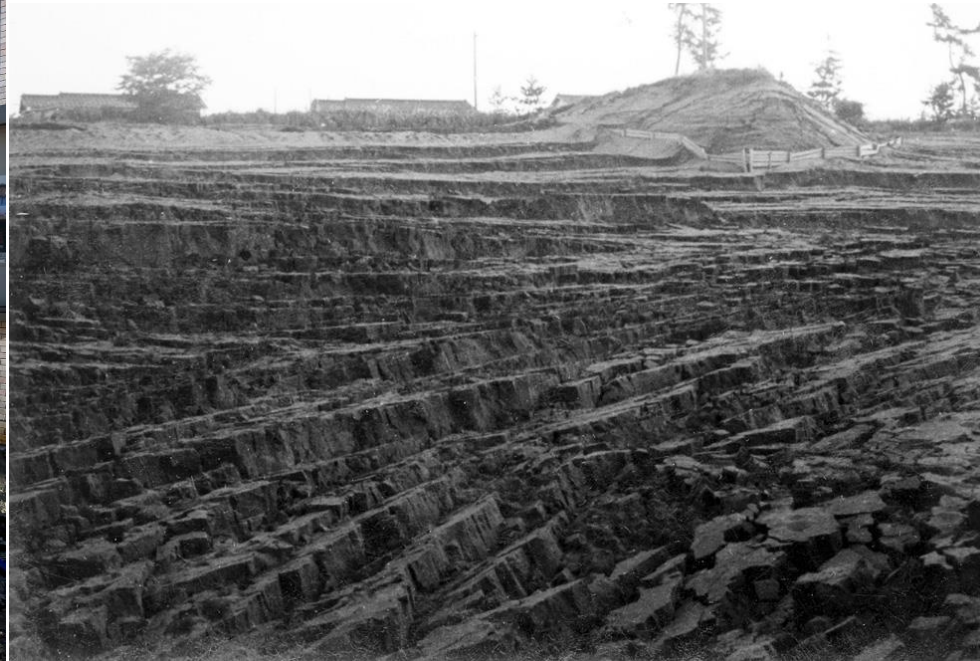
図20 1964年新潟地震時の砂丘の階段状滑り 7)
