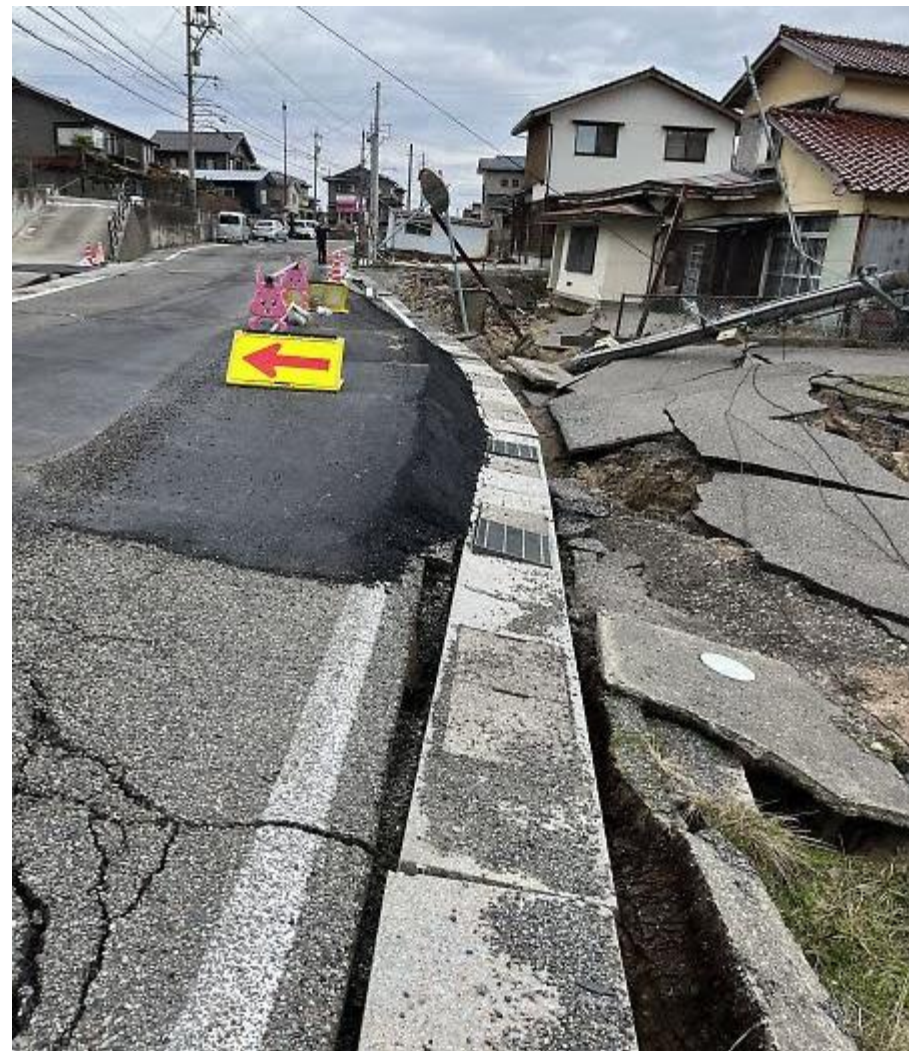
図67 内灘町室県道162号室北バス停付近
