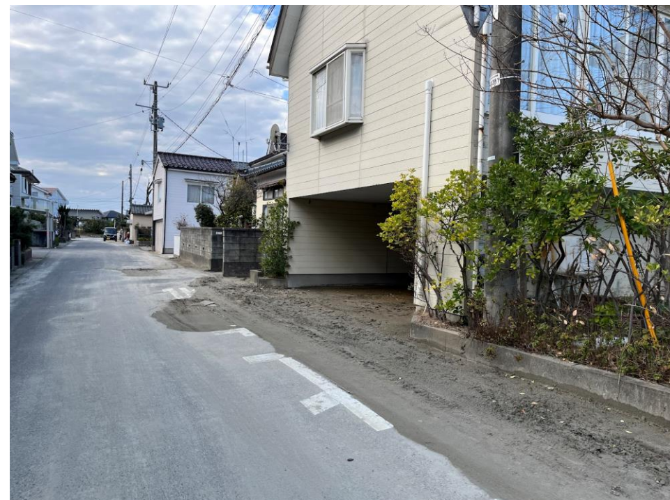
図30 新潟市西区ときめき西2-3-20 (37.876128N, 139.009461E, 方位角287.8857° )
