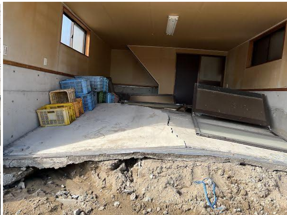
図61 図60の右手の建物の内部。
