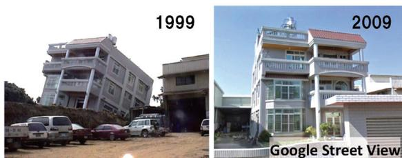
写真1 1999年台湾・集集地震の際、逆断層変位すべりの直上で大きく傾斜した3層RC造住宅（左）と修復後の様子（右）
