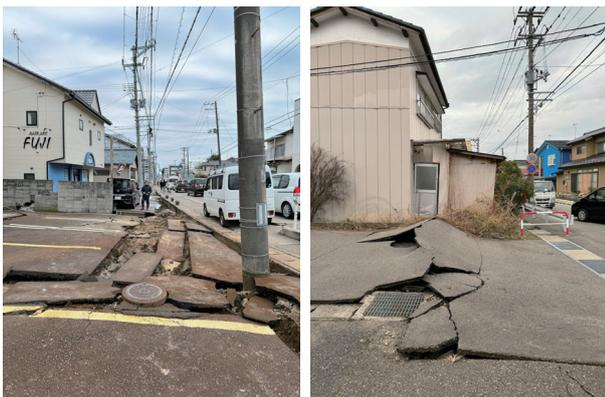
図3 県道16号線沿いに生じた地盤変状 (a) 引張亀裂と斜面下方への滑り (b) 斜面末端で生じた舗装の隆起
