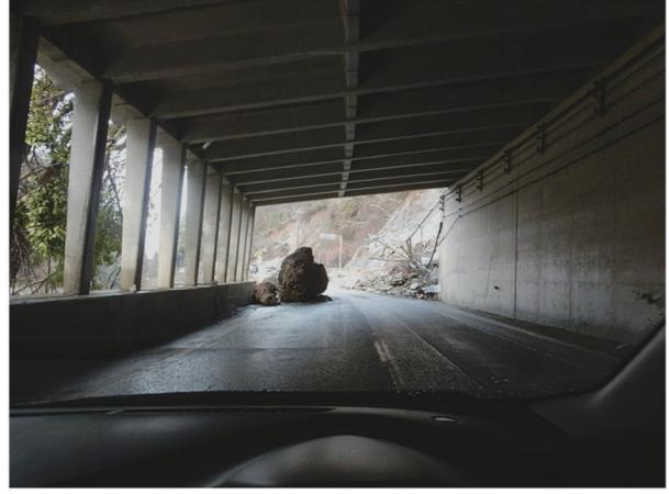
写真5 石川県道1号の落石・斜面崩壊状況
