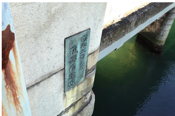
写真1 山王橋に記された復興局建造の銘板
