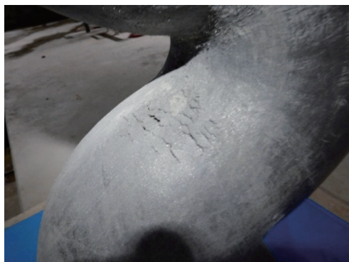
図5 鉛ダンパーのクラック
