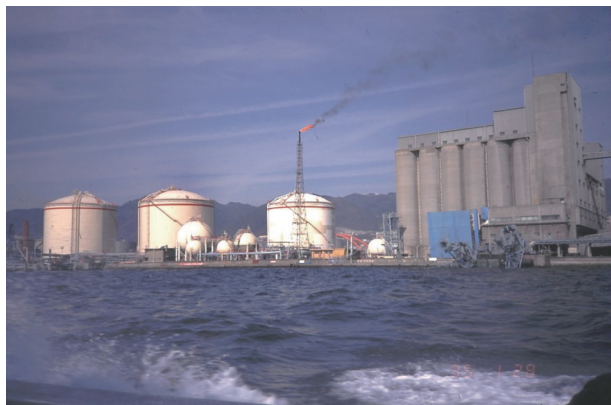
写真1 地震の3日後に撮ったLPガス基地の被害
