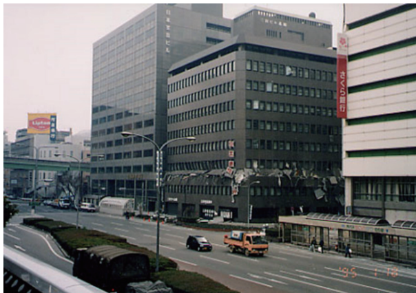
写真1 神戸三宮駅南の被害例：真ん中の建物では3階が崩壊してしまったが、左の建物はしっかりと立っている（1995年1月18日朝、筆者撮影）。
