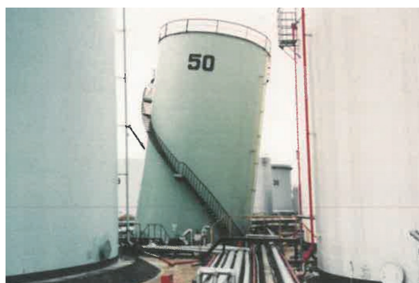
図2 地盤変状により傾斜した円筒タンク (1)
