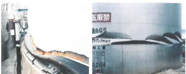
図4 円筒タンクの象足座屈とダイヤモンド座屈 (1)
