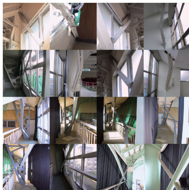
写真1 鉛直ブレースの画像の例
