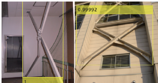
写真2 Faster R-CNNによる鉛直ブレース検出の例
