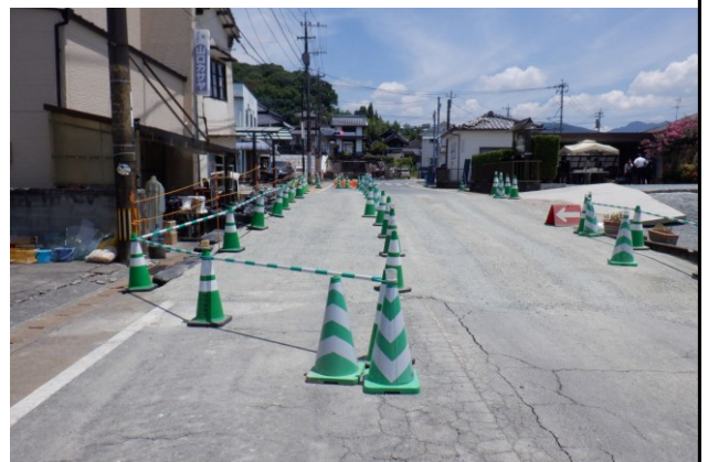
地震で生じた段差を補修した後
