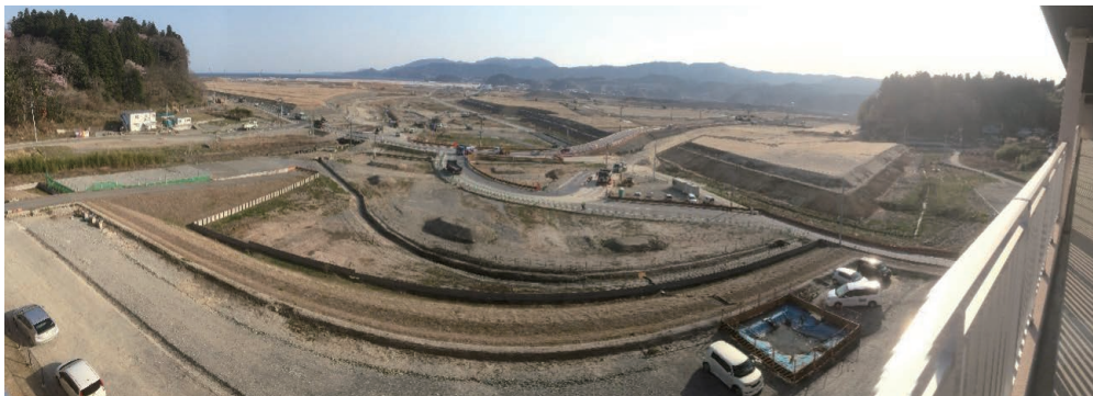
写真1 復興の工事が進む陸前高田市の中心部(2016年4月12日、パノラマ撮影)
