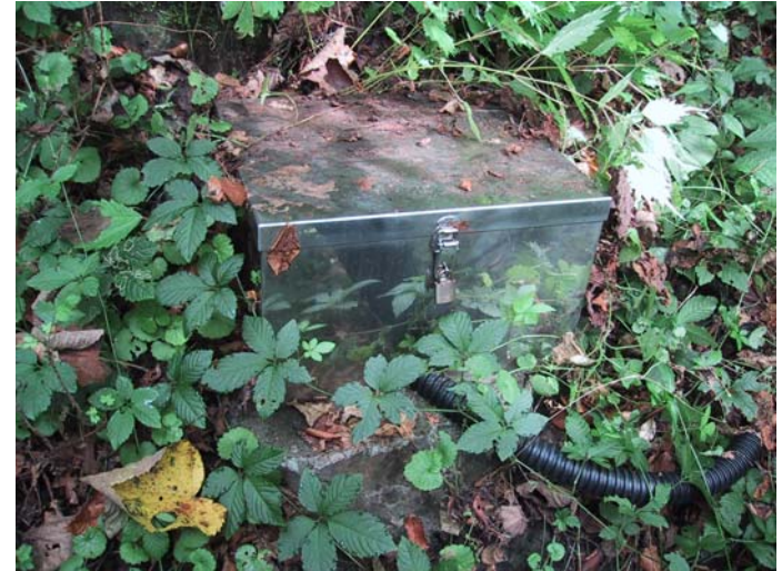
露頭岩盤に設置された強震計 (久慈:岩手県)
