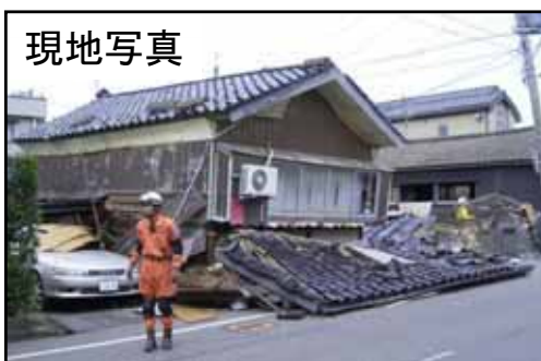
新潟県中越沖地震において1階部分が崩壊した家屋
