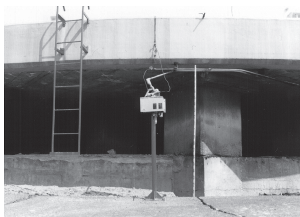
図6 地盤変状（沈下）による漏洩検知器導管の損傷
