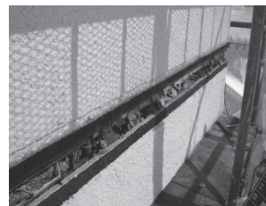
写真2 外壁切断
