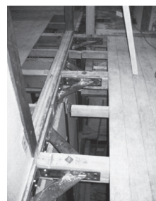
写真6 切断部補修(梁)
