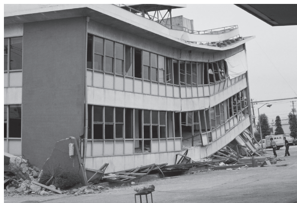
写真2 太平洋魚業の建物。1階が倒壊している。
