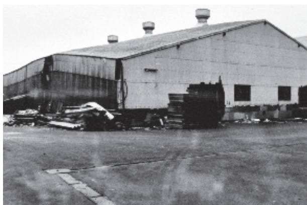
写真3 鉄骨造2階建て倉庫の崩壊
