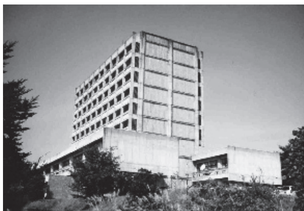
写真7 東北大学工学部建設系建物(改修前)
