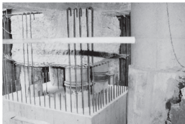
写真5 基礎杭頭の補修と補強
