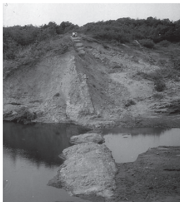
写真1 決壊した一里小屋ダム
