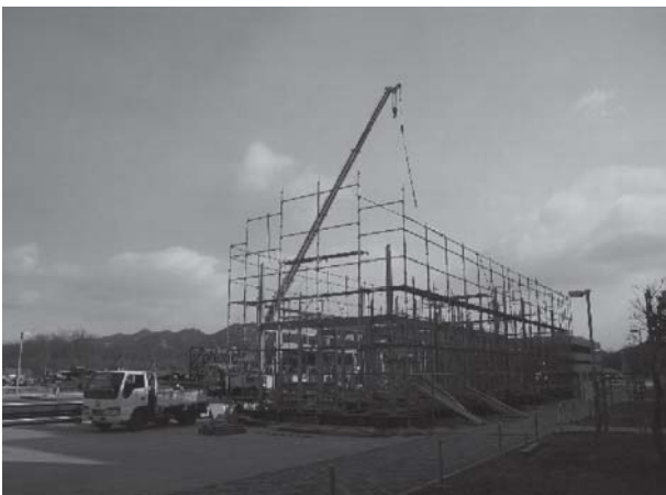
写真8 試験体の解体写真
