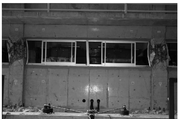
写真4 既存RC試験体の破壊状況 (Run6)
