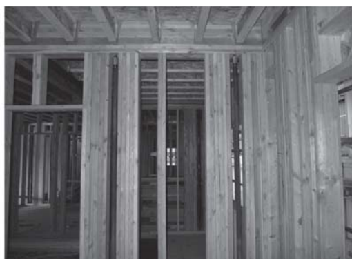
写真4 ATSシステム (最上階までロッドが壁内を貫通)
