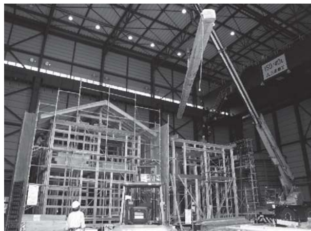
写真1 2008年度伝統的軸組構法木造試験体の組立
