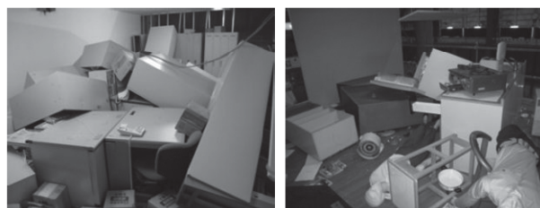
図7 高層建物上層階家具什器の散乱
