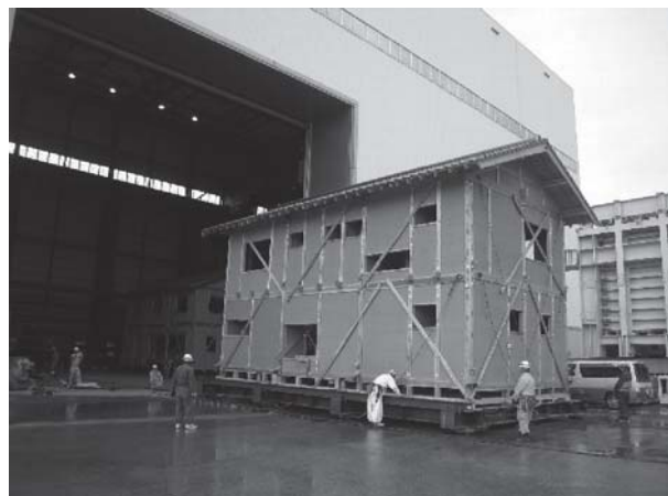
写真4 試験体の曳家作業
