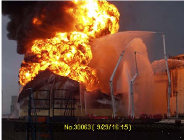
写真2 地震の2日後に発生した全面火災
