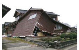
写真8 倉庫の被害例
