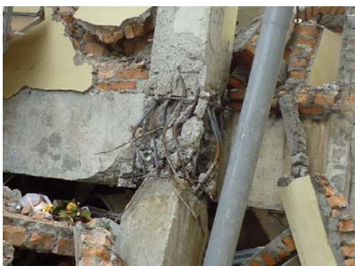
写真6 接合部の破壊事例(インドネシア・スマトラ島西部地震)
