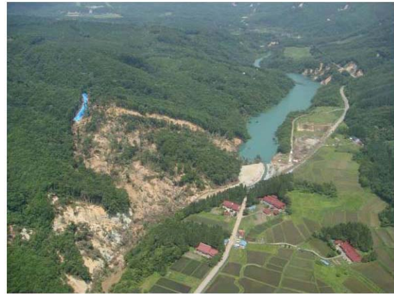
写真2 岩手県一関市市野々原の河道閉塞箇所
