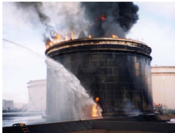
写真1 地震直後のリング火災
