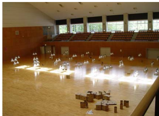
写真1 体育館の照明器具の落下 2) (東山新町民体育館)
