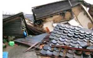
写真9 土蔵の被害例
