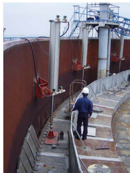
写真3 容量15,000kl浮屋根式タンクの揺動実験
