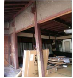
写真2 同 柱折損
