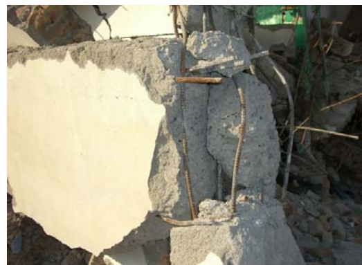
(b) 柱梁接合部破壊
