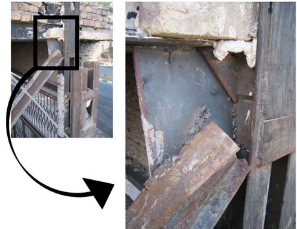
写真2 鉄骨桝架構の溶接部破断(イラン・バム地震)
