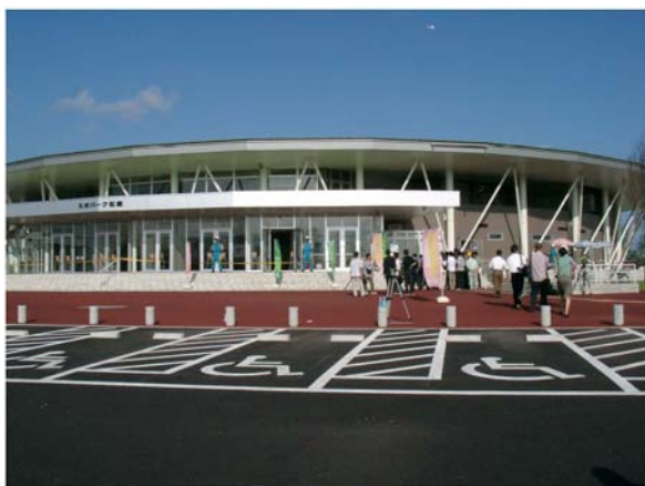
写真2 被害を受けた屋内プール建屋
