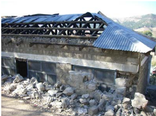
(a) 無補強組積構造(石積み)
