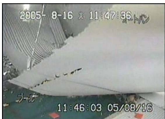
写真3 つり天井の落下状況(監視ビデオ映像より)
