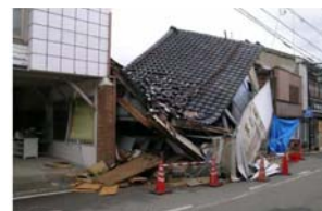
写真7 店舗の被害例
