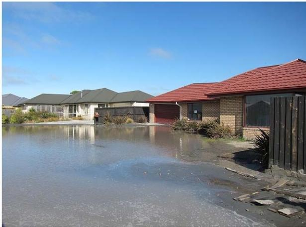
写真9 液状化被害の様子 (東部郊外Bexley地区)
