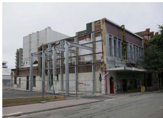
写真7 応急補強により被害を免れたURM建物(CBD)
