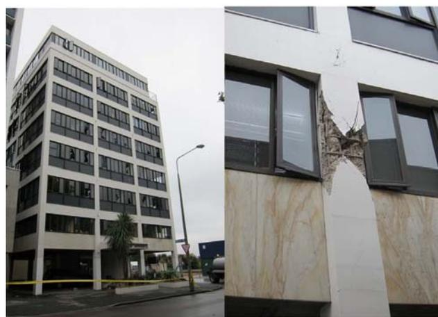
写真6 柱と柱梁接合部に被害が生じたRC造建物(CBD)
