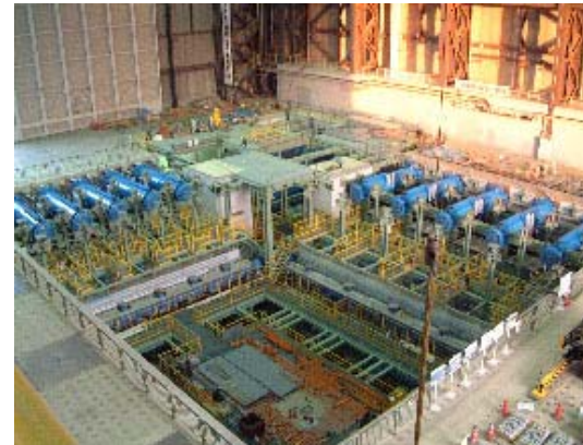
図4 加振機の据付完了状況 (平成15年1月)
