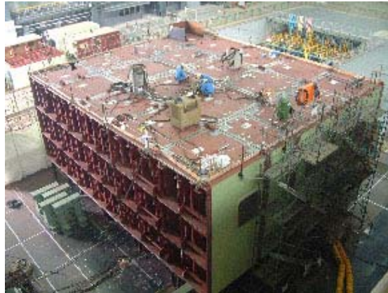
図5 震動テーブル(一部)の現地溶接開始(平成15年6月)
