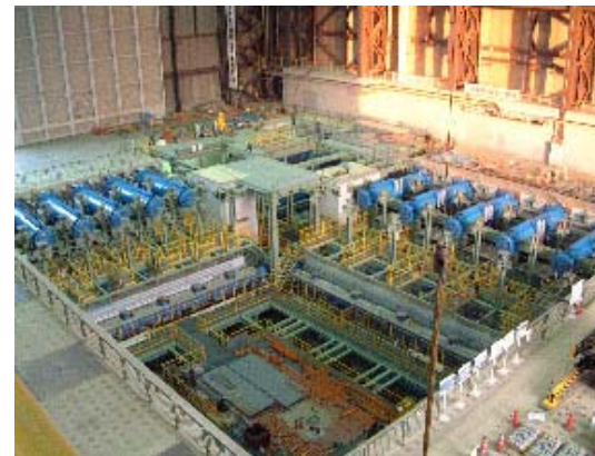
図4 加振機の据付完了状況 (平成15年1月)
