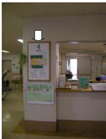
写真4 地震時に落下したとされるパネルの例(建築物A、4階)
