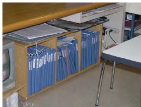
写真5 地震時に机の下から飛び出したとされるキャスター付きファイルケース(建築物A、4階)
