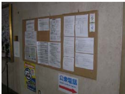
写真8 地震時に大きく揺れたとされるパネルの例 (建築物B、1階)
