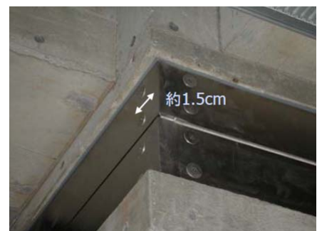
写真3 柱頭免震部積層ゴム支承の カバー (図3の(a)部分)
