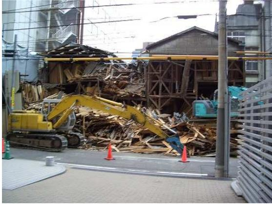
写真13 福岡舞鶴震度計（震度6弱）付近の大きな被害を受けて取り壊される木造建物（2005年福岡県西方沖地震）
