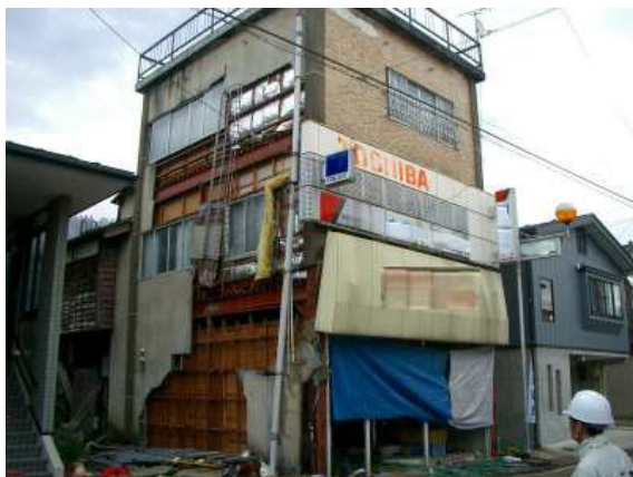
写真 20 中破の被害を受けた S 造店舗(90)
