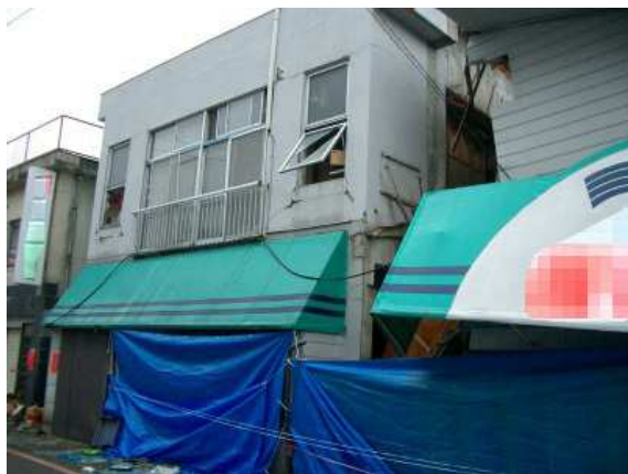
写真14 中破の被害を受けたRC造店舗(78)
