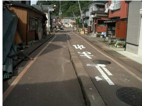
写真 11 被害が多い地域の様子
