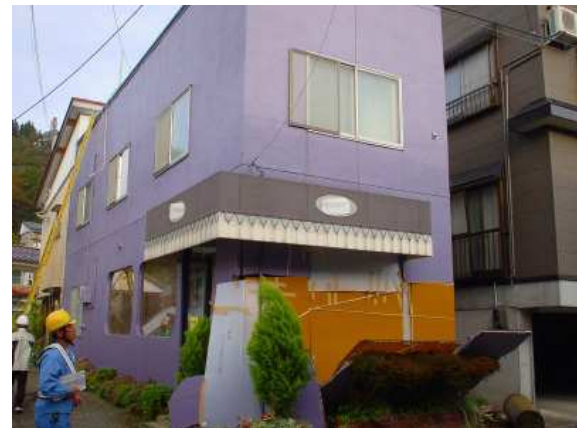
写真 19 中破の被害を受けた S 造店舗(23)
