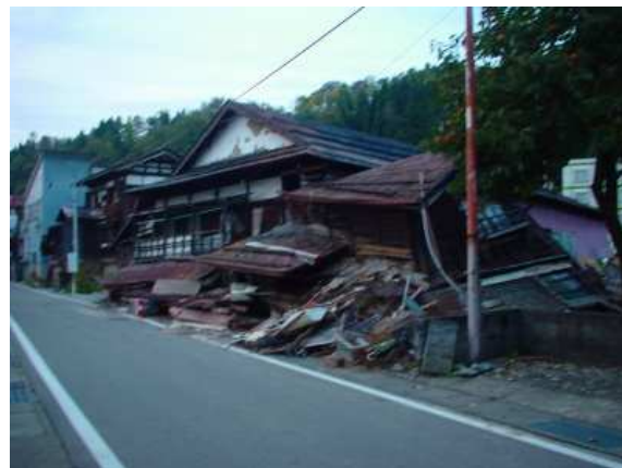
写真 25 全壊した木造住宅(27)
