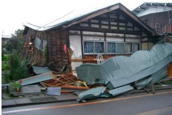
写真 24 全壊した木造住宅(64)
