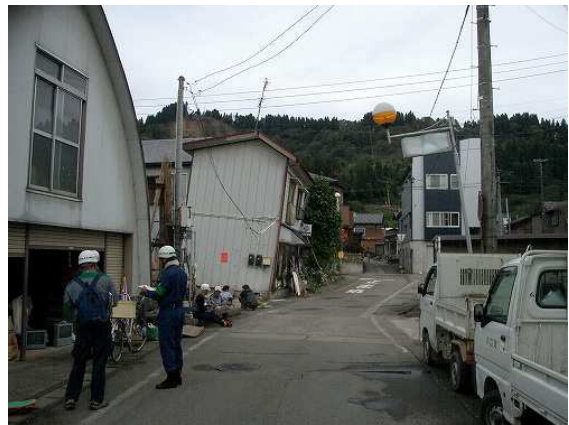
写真7 被害が多い地域の様子
