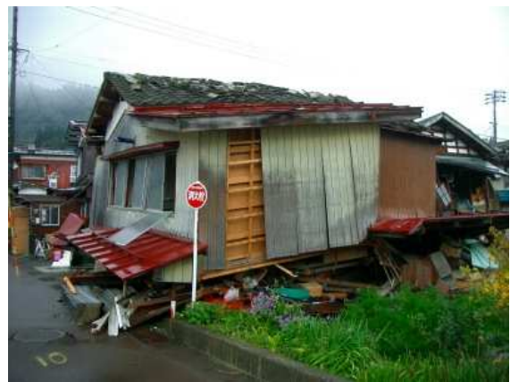
写真 23 全壊した木造住宅(62)
