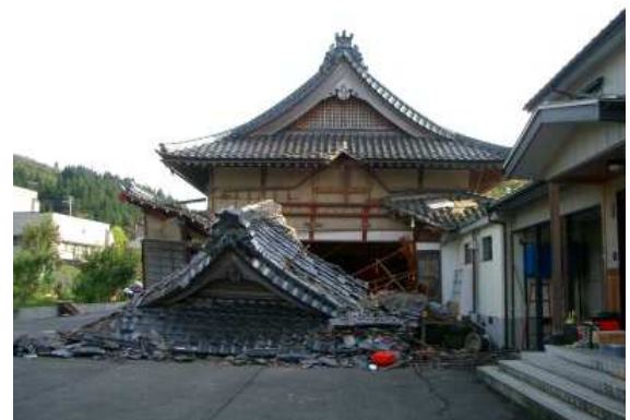
写真 21 全壊した木造建物(10)
