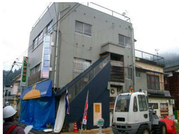
写真15 中破の被害を受けたRC造店舗(92)
