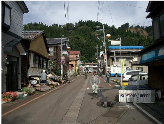
写真 10 被害が多い地域の様子
