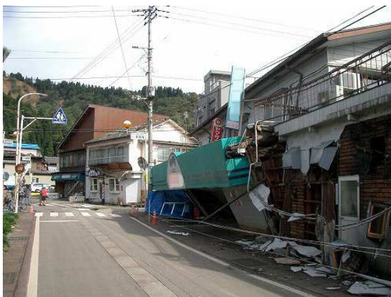
写真8 被害が多い地域の様子
