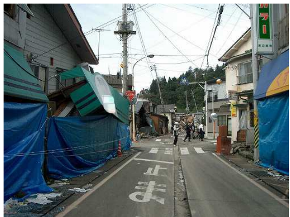
写真9 被害が多い地域の様子
