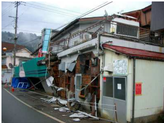
写真 18 大破した S 造店舗(77)
