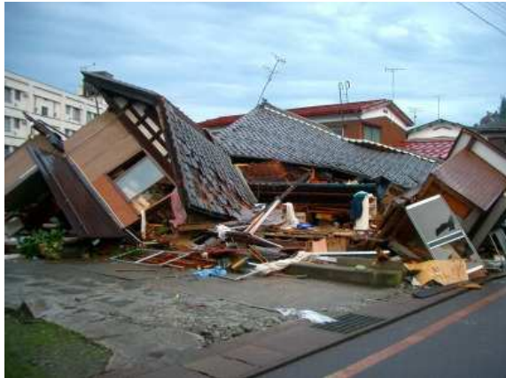
写真 22 全壊した木造住宅(39)
