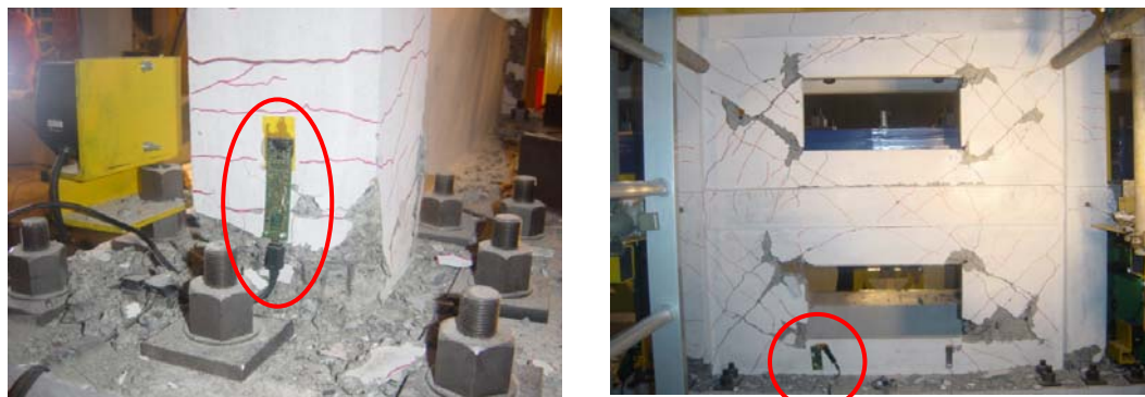
写真4 センサ設置周辺の模型ひび割れ状況 (左：センサA、右：センサE)
