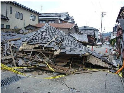
写真 8.11 倒壊した木造倉庫建物
