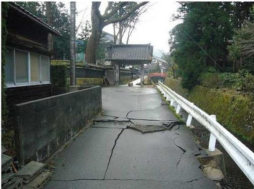
写真 9.17 地盤の被害
