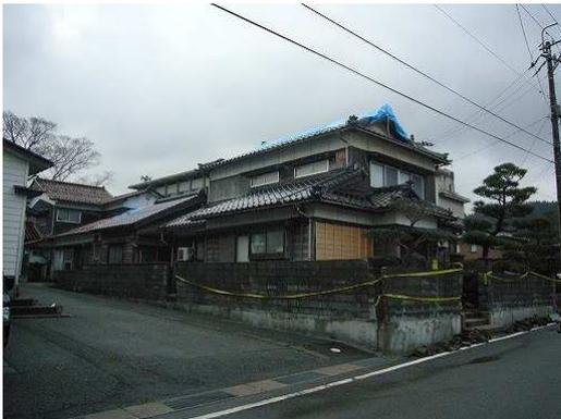
写真 9.15 屋根瓦の被害
