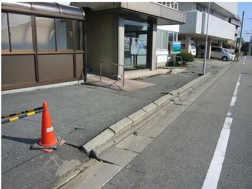
写真 3.13 地盤の被害
