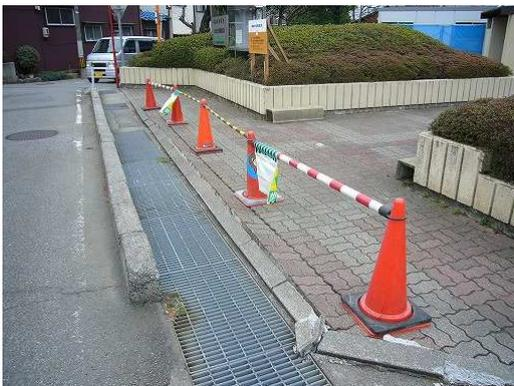
写真 8.3 庁舎建物周辺の地盤の被害
