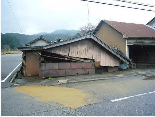
写真 9.13 倒壊した木造倉庫建物
