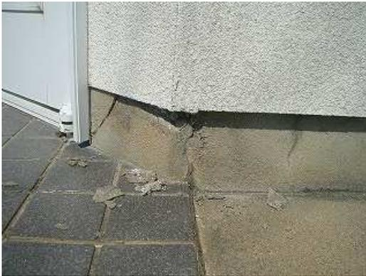
写真 2.7 木造建物の軽微な基礎の被害
