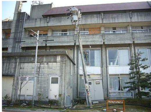
写真 3.4 役場建物周辺の地盤の被害（電柱の傾き）
