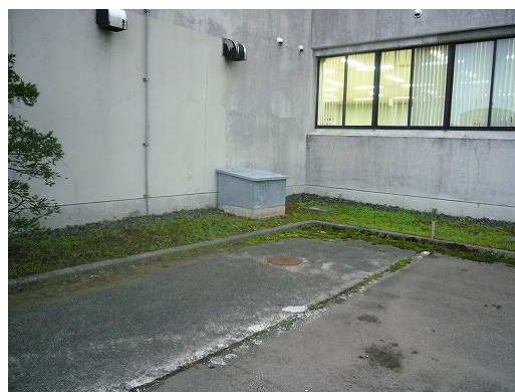
写真 4.2 震度計の設置状況
