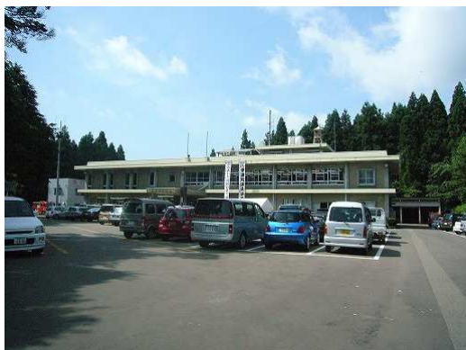
写真 8.1 出雲崎町役場建物
