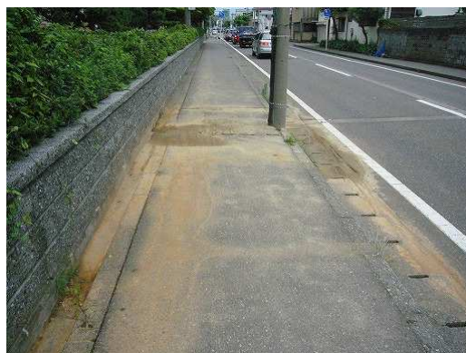
写真 1.22 地盤の液状化による噴砂
