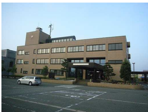
写真 5.1 長岡市三島支所建物
