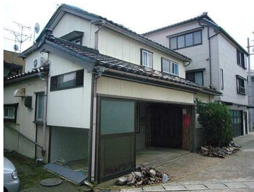
写真 1.20 屋根瓦の被害
