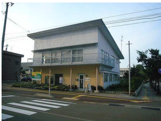
写真 13.3 補修された木造建物
