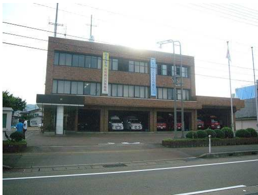
写真 13.1 小千谷地域消防本部建物
