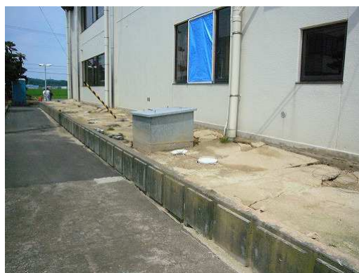
写真 10.2 震度計の設置状況
