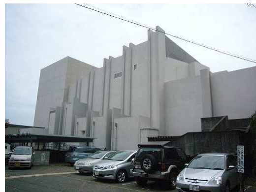
写真 1.2 柏崎市市民会館建物
