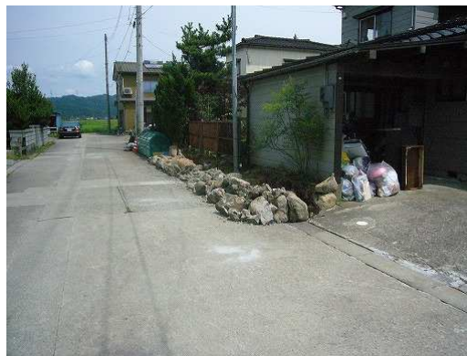
写真 10.14 倒壊した塀
