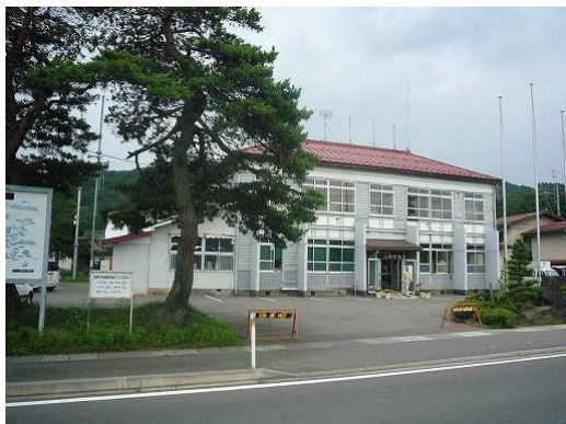
写真 16.1 飯綱町役場三水庁舎建物
