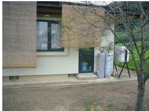
写真 16.12 軽微なひび割れが見られる木造建物
