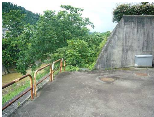
写真 11.2 震度計の設置状況
