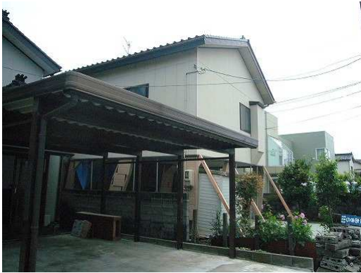
写真 1.13 全壊した木造建物
