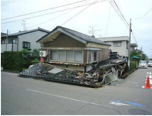
写真 1.11 全壊した木造建物
