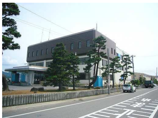
写真 10.1 刈羽村役場建物
