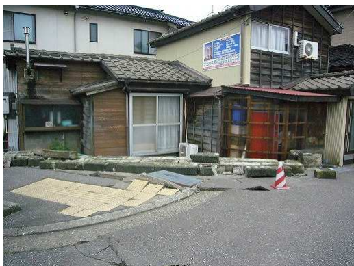
写真 1.21 地盤の被害
