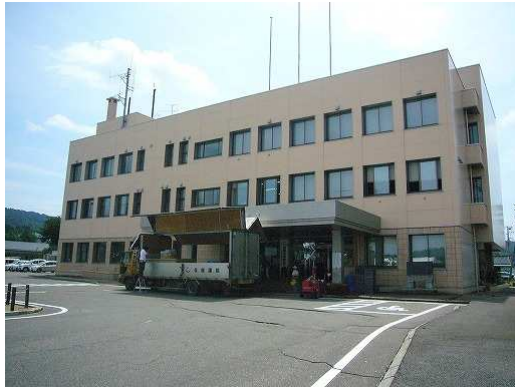
写真 9.1 柏崎市西山町事務所建物
