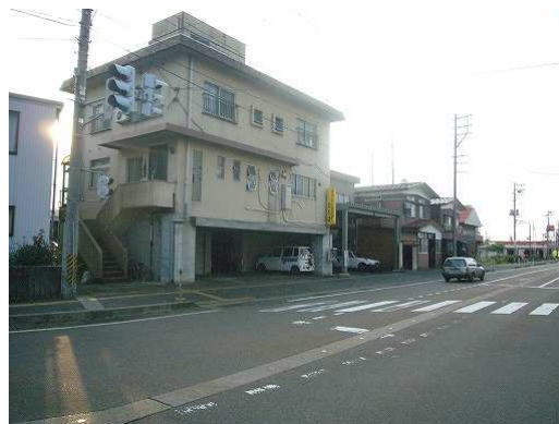
写真 13.4 補修された鉄筋コンクリート造建物
