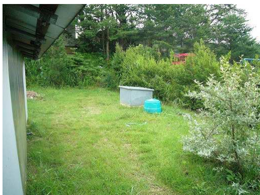
写真 3.3 震度計の設置状況
