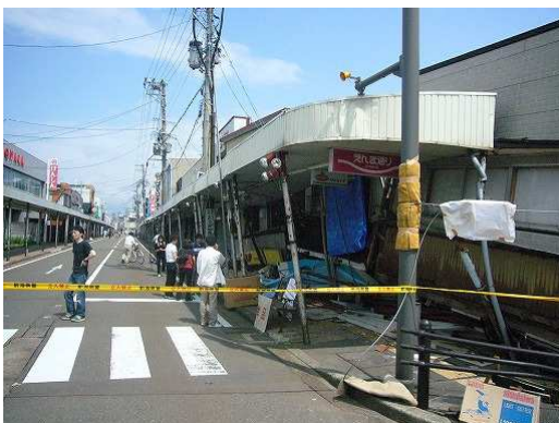
写真 1.17 大きな被害を受けた商店街
