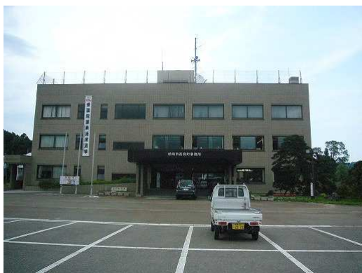
写真 11.1 柏崎市高柳町事務所建物
