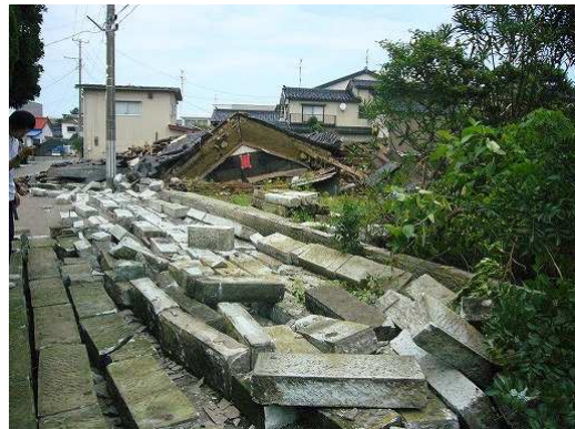
写真 1.16 全壊した木造建物と塀の倒壊
