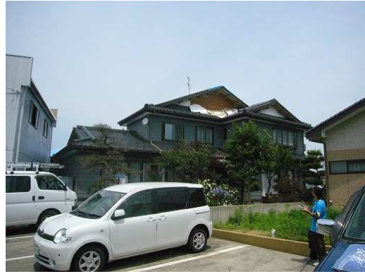
写真 9.8 全壊した木造建物
