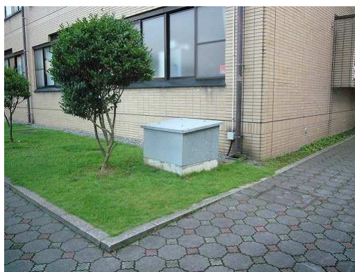
写真 5.2 震度計の設置状況
