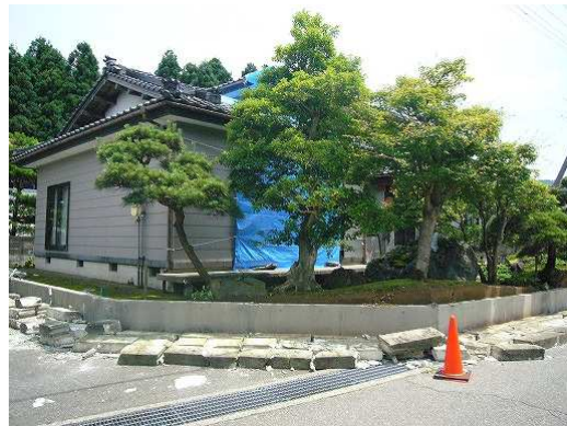
写真 9.12 塀，屋根瓦，ガラスが破損した木造建物
