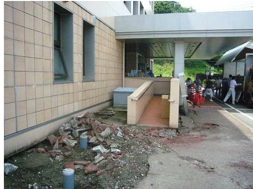
写真 9.2 震度計の設置状況
