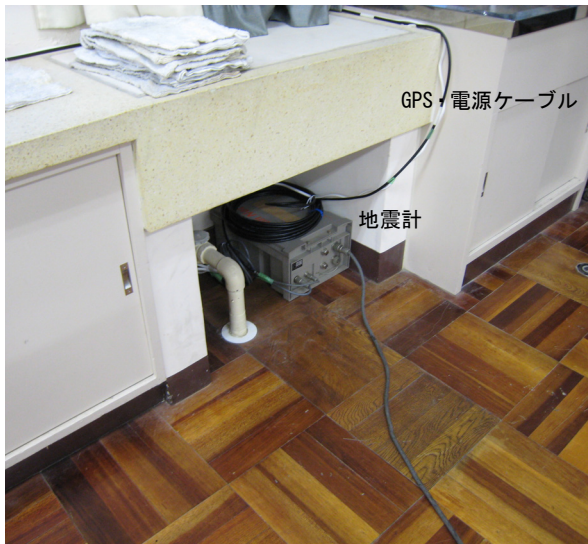
図 6 高校の理科室における強震計設置例
