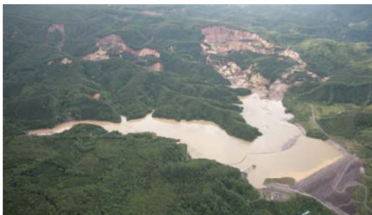
写真1 荒砥沢ダム上流の地すべり(朝日航洋提供)
