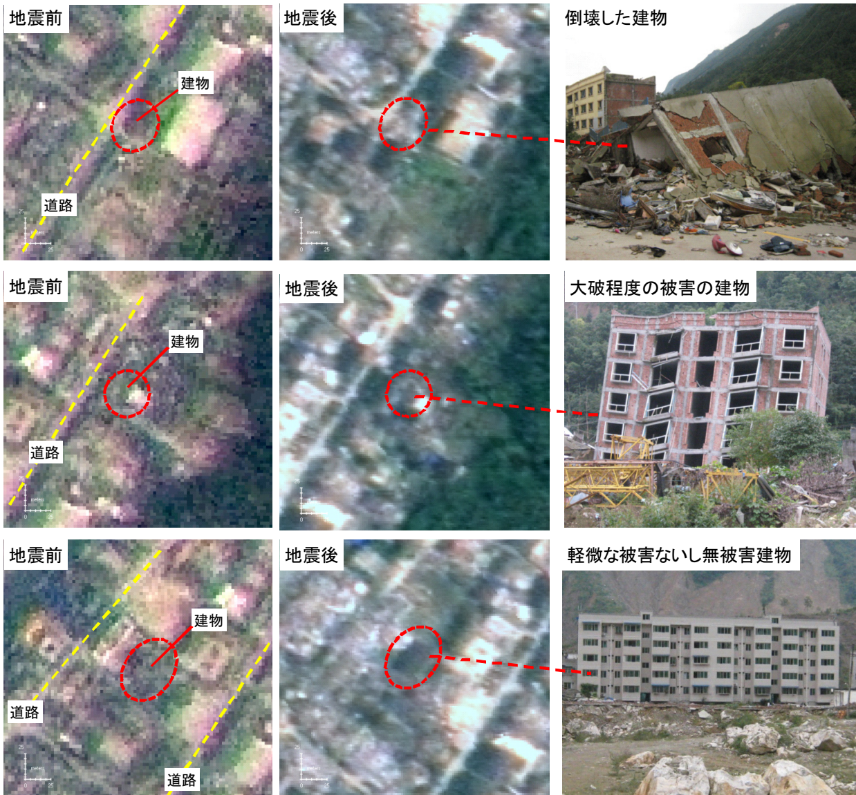
図5 各被害程度の建物に対する地震前、地震後の画像および現地写真の比較
