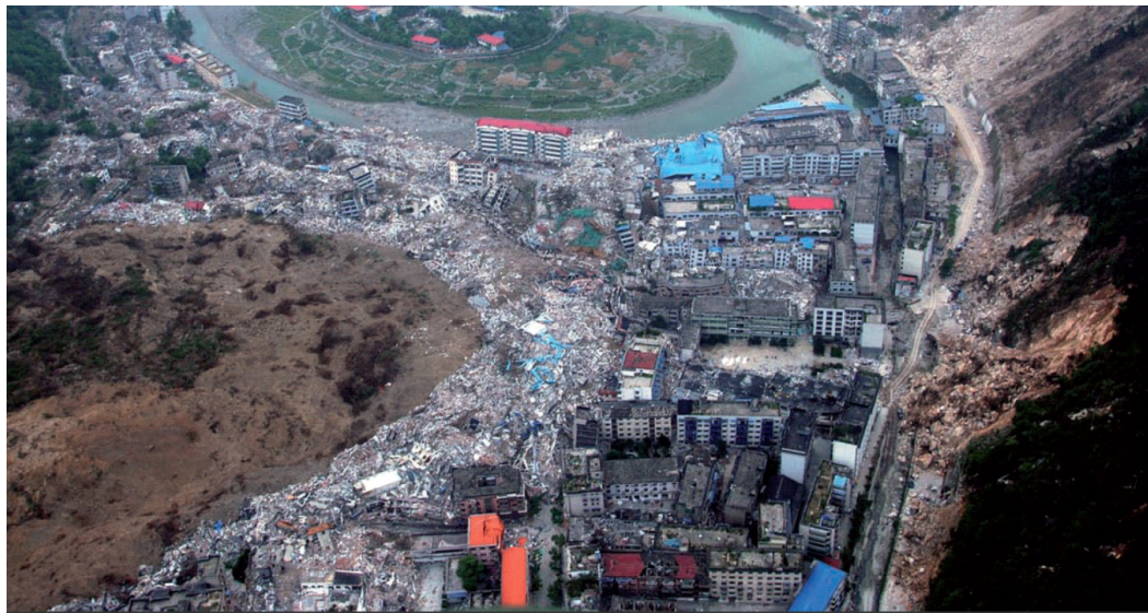
図 2 四川省北川県曲山鎮における被害 16)
