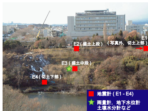
図2 谷埋め盛土斜面の全景
