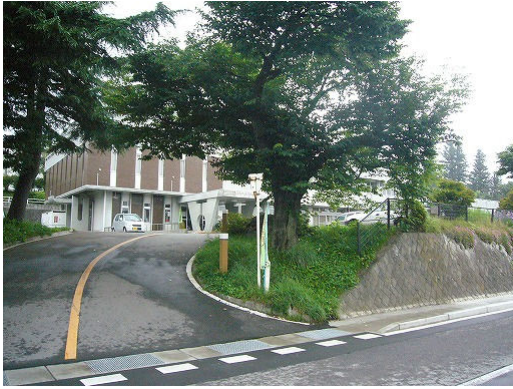
写真 6.3 洋野町役場大野庁舎のある高さ
