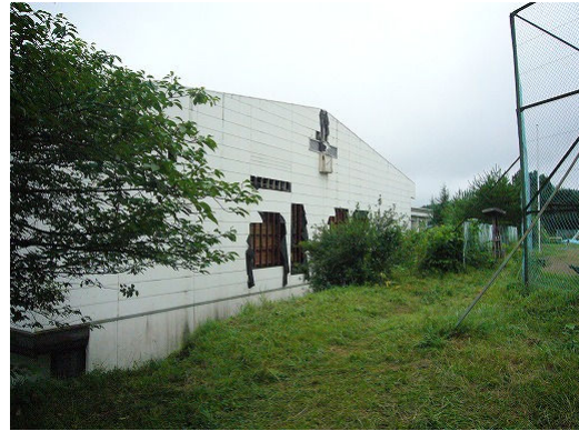
写真 6.14 体育館の外装材の落下
