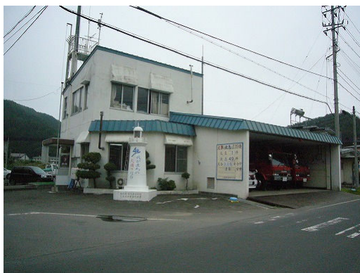
写真 8.1 久慈消防署普代分署建物
