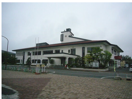
写真 7.1 野田村役場建物
