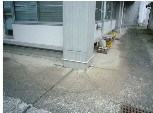
写真 6.6 地盤変状に伴うひび割れ
