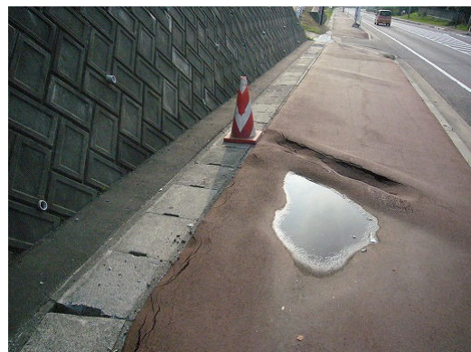
写真 3.8 地盤の変状による舗道の被害
