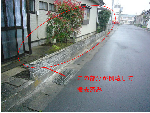
写真 5.9 ブロック塀の被害
