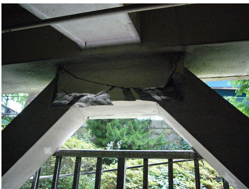
写真 1.11 ブレースの損傷
