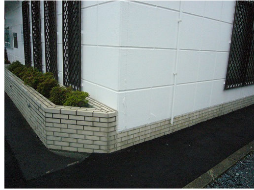
写真 5.10 鉄骨造銀行建物の外装材の剥落
