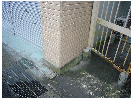
写真 5.12 商店の基礎部の軽微なひび割れ
