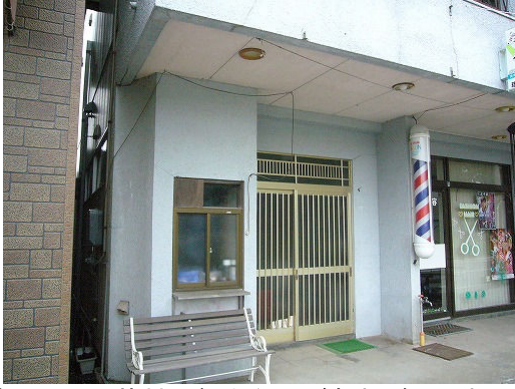
写真 6.11 外装材に軽微なひび割れが見られる建物
