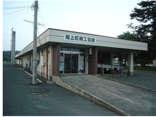
写真 4.4 外壁に軽微なひび割れ（写真 4.5） が見られる階上町商工会館建物
