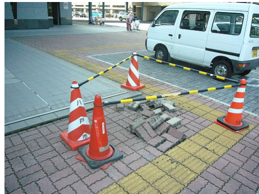
写真 1.8 地盤変状によるタイルの損傷
