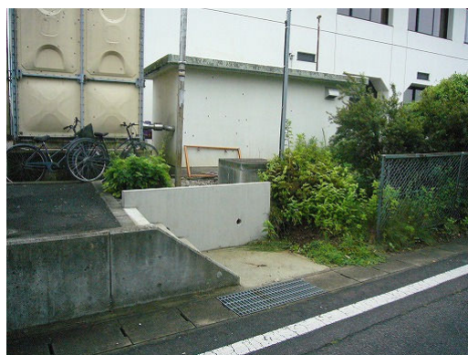
写真 7.2 震度計の設置状況
