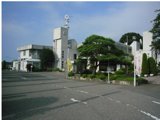
写真3.1 八戸市南郷区役所建物
