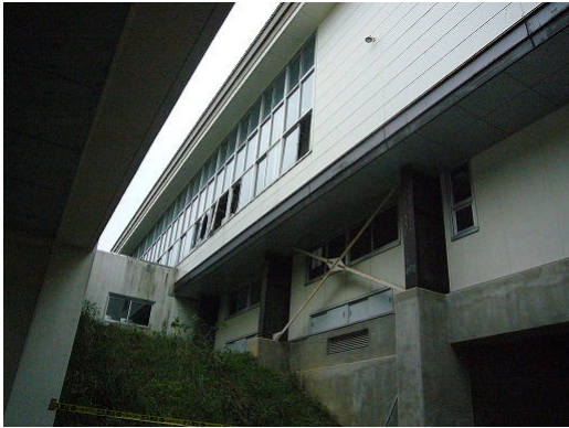
写真 6.13 体育館のガラスの被害
