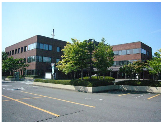
写真 2.1 五戸町役場建物
