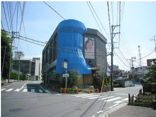
写真 1.9 ガラスブロックが落下した建物
