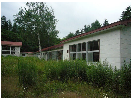
写真 10.1 旧玉山村立藪川小学校亀橋分校建物
