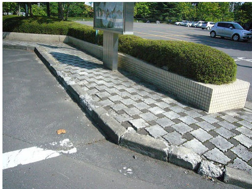
写真 2.5 地盤変状に伴うブロックの損傷
