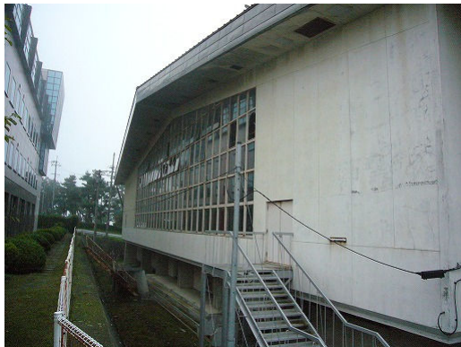
写真 5.11 体育館のガラスの被害
