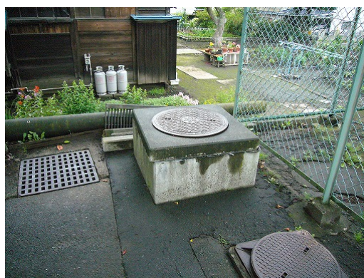
写真 6.2 震度計の設置状況
