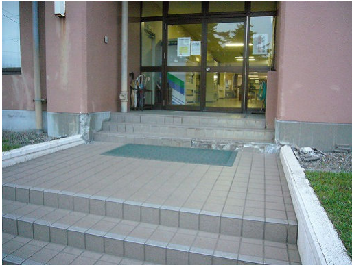
写真 4.3 役場建物入口の損傷
