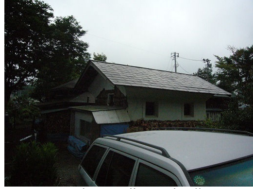
写真 6.12 蔵の土壁の落下
