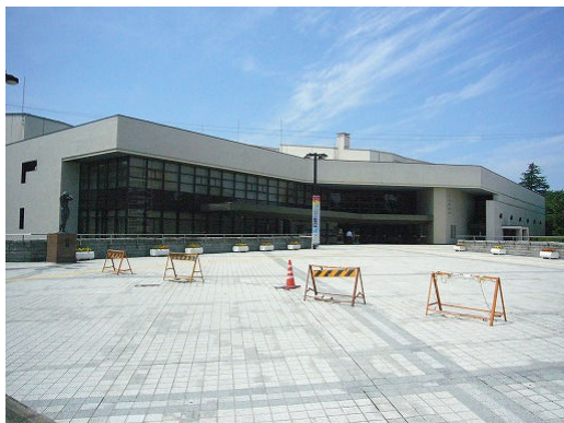
写真 1.1 八戸市公会堂建物と 地盤変状によるタイルの損傷
