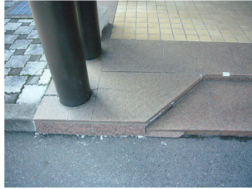
写真 2.4 地盤変状に伴うタイルのひび割れ
