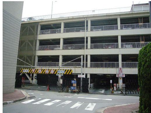
写真 1.10 ブレースと階段に損傷がある 駐車場建物
