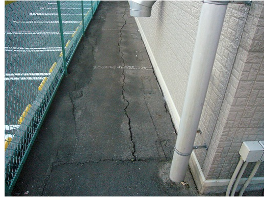
写真 4.10 地盤変状に伴うアスファルトのひび割れ
