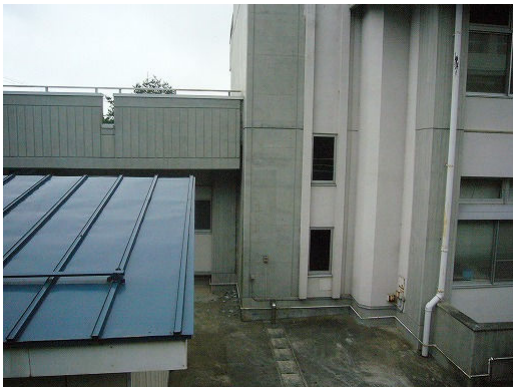
写真 6.5 役場建物の繋ぎ目の損傷
