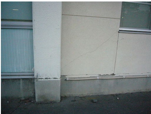
写真 4.5 外壁に軽微なひび割れ
