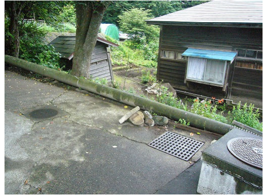
写真 6.4 震度計の脇の段差
